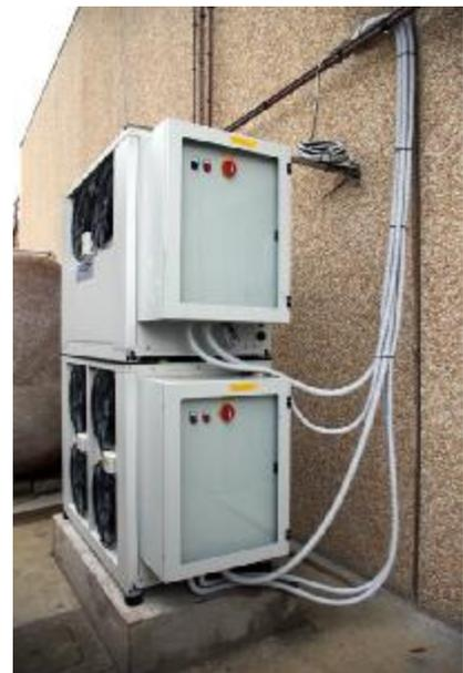
**Lo sbrinamento delle batterie del freddo** avverrà con il gas caldo di compressione. Questo ciclo di funzionamento verrà gestito e comandato automaticamente dallo strumento per mezzo della apertura-chiusura di elettrovalvole.
