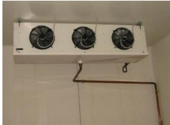
**La sezione frigorifera** dimensionata per funzionare con Freon R507, farà capo ad un gruppo motocondensante monoblocco da esterno.
