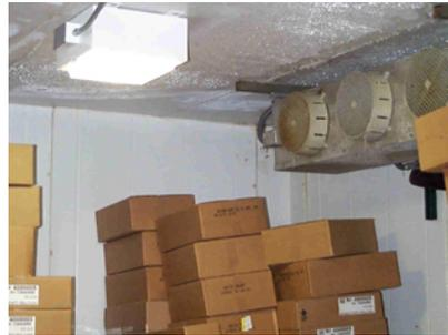
**Isolamento insufficiente in una cella frigorifera accessibile**
