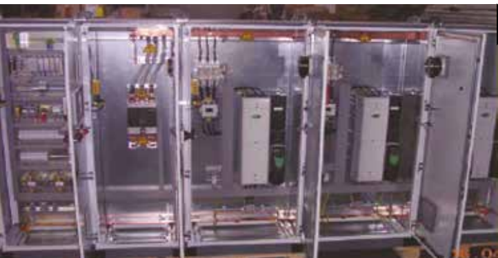
Quadro Fiat Cassino per la gestione automatica delle pompe di alimento saldatrici reparto saldatura (mantenimento pressione costante con variazione di set point tramite calendario)
