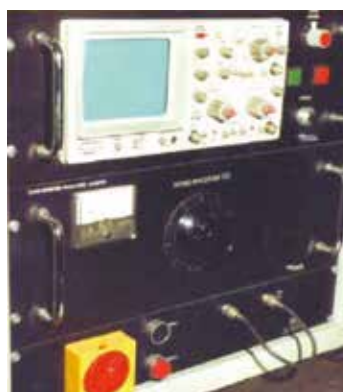
Quadro Fiat Cassino per la gestione automatica delle pompe di alimento saldatrici reparto saldatura (mantenimento pressione costante con variazione di set point tramite calendario)
