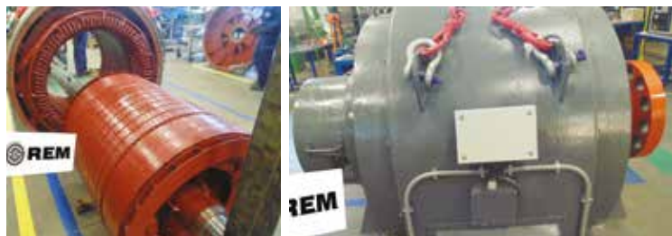
Revisione completa motore Savigliano A8000H/6 KW1350. Montaggio di sistema di controllo delle vibrazioni e temperatura dei cuscinetti.
