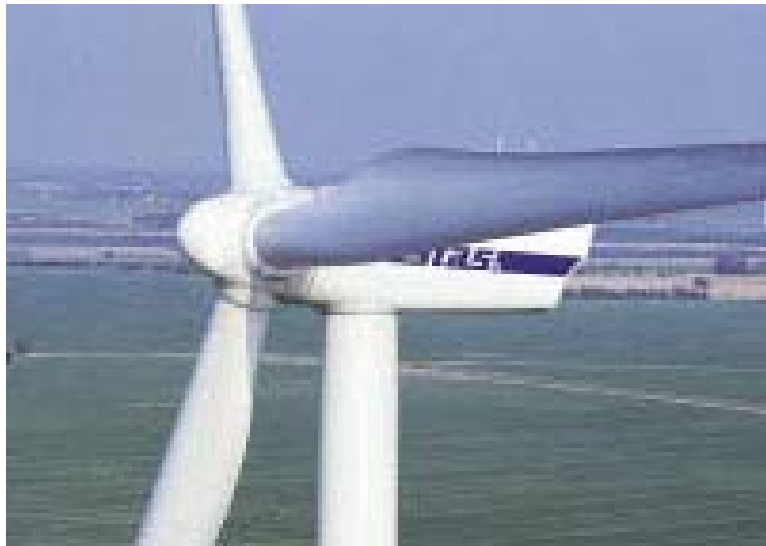
Fig. 1: Vestas V90 3.0 MW wind generator. Source: Vestas.
