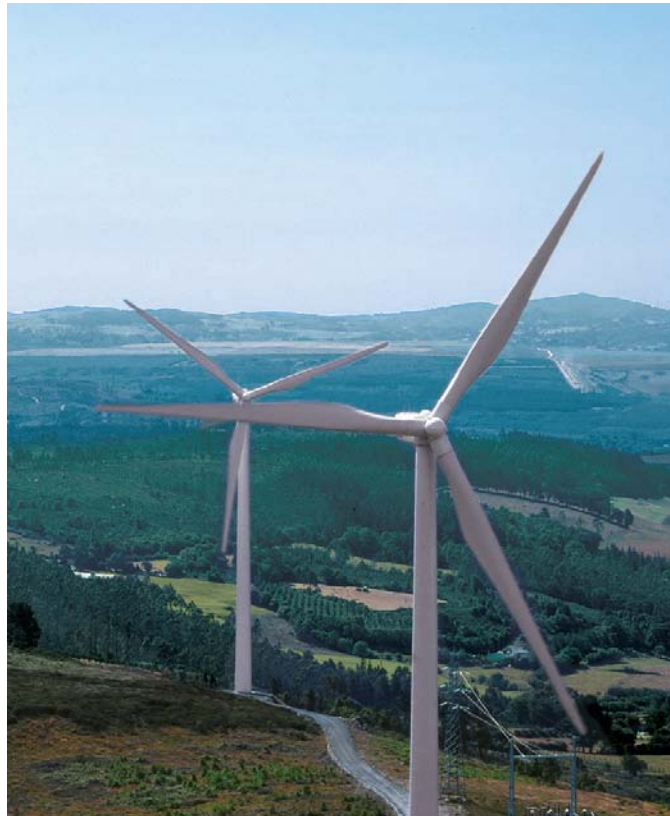
Fig. 62: Ecotènia wind turbines. Source: Ecotènia.
