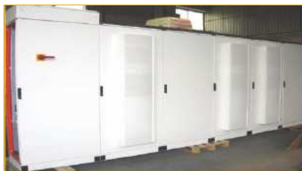
Quadro comando linea taglio lamiera Fiat Cassino – Centro Presse (29 mt di carpenterie – tre PLC S7-300 319F in rete – otto pannelli operatori – 32 azionamenti in rete – cinquantacinque en-coder per posizionamento - circa 2200 I/O)
