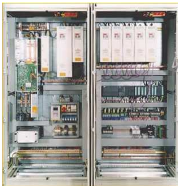
Quadro comando linea taglio lamiera Fiat Cassino – Centro Presse (29 mt di carpenterie – tre PLC S7-300 319F in rete – otto pannelli operatori – 32 azionamenti in rete – cinquantacinque en-coder per posizionamento - circa 2200 I/O)
