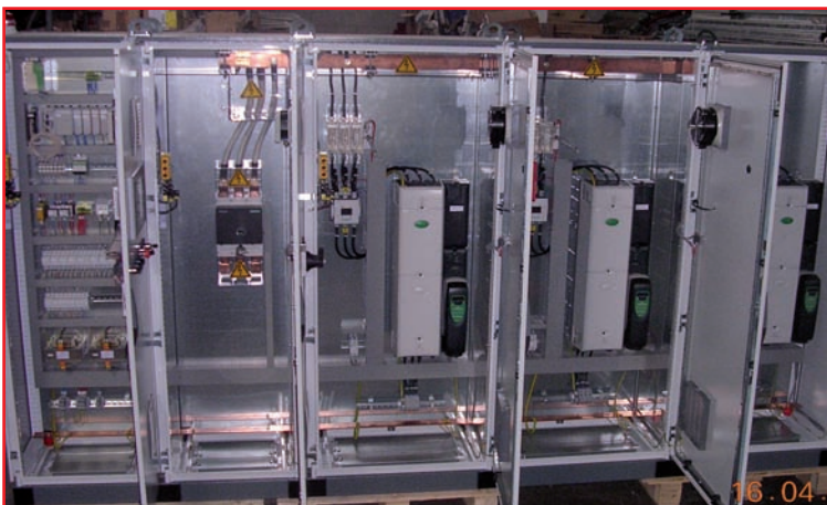
Cadru Fiat Cassino pentru controlul automat al pompelor de sudari alimentare din departamentul de sudare (mentinerea presiunii costanta cu variatie de set point calendaristic) (valoare nominala calendaristica)
