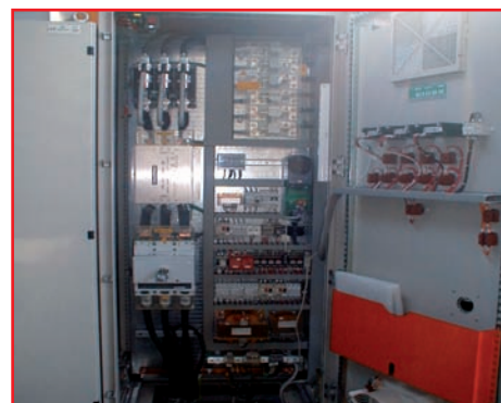
Cadru gestiunea motorului de curent alternativ cu bucla inchisa 264Kw
