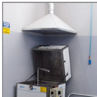
Installazione cappa Extractor hood installation
