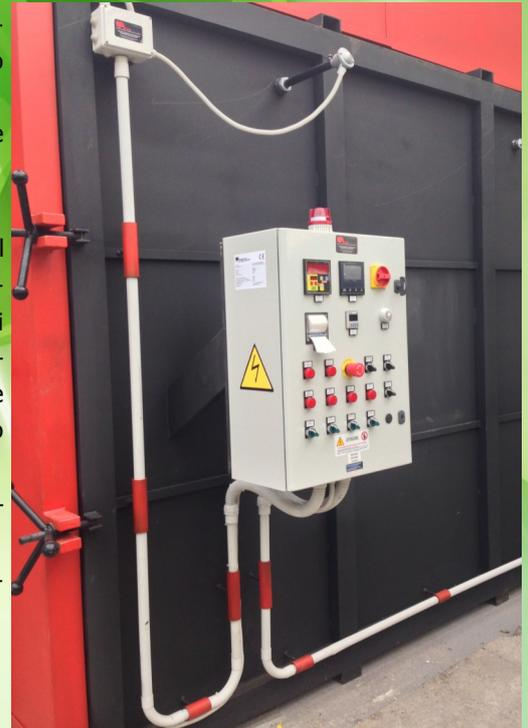
In funzione della specifica applicazione a cui è destinato l'impianto è possibile installare un apparecchiatura di programmazione che permetterà di controllare, mediante un sistema a microprocessore, **fino a 10 tipologie di cicli** in modo da soddisfare, nella maniera più idonea, le più svariate esigenze del cliente impostando il ciclo in relazione alle esatte quantità ed alle diverse tipologie di materiali da trattare.
