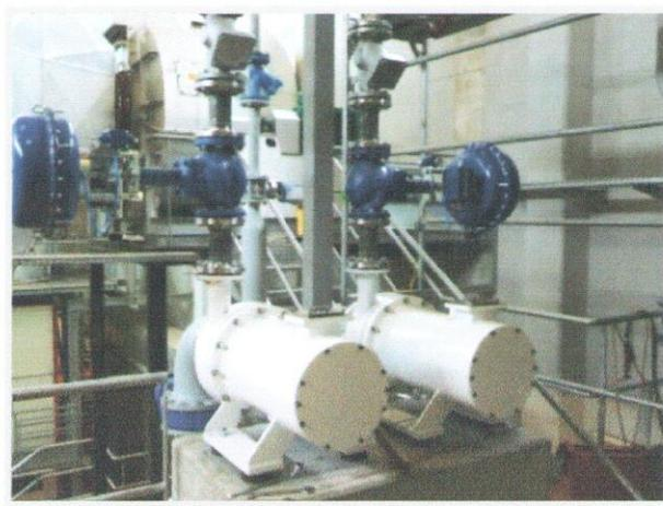
Figura 1: Immagini di una coppia di turbogeneratori di recente installazione aventi una potenza elettrica complessiva di 300 kW.
