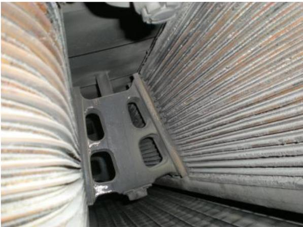
Figura 25: bobine non deformate
