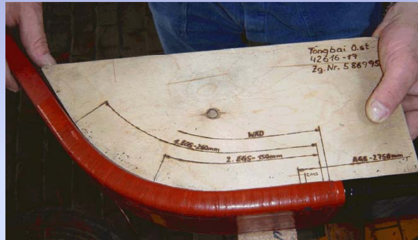
Posa dei nastri semiconduttori in testata
