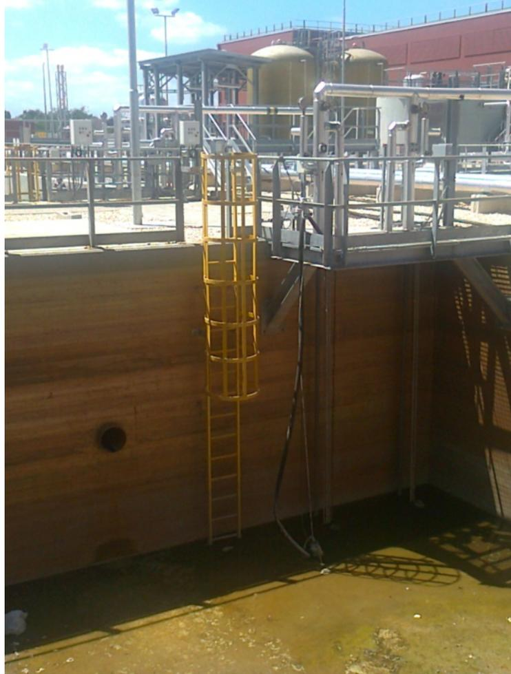
L'unico accesso alla vasca di prima pioggia avviene tramite scale alla marinara. La vasca ha una profondità di 4300 mm (4600 nel pozzetto pompe di sentina) ed una sezione di 9000 \* 14000 mm. Può raccogliere una volumetria massima di 540 m<sup>3</sup> di acqua. Il bordo della vasca è interamente confinato con ringhiera di protezione alta 120 cm.
