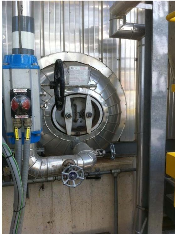
Il diametro interno dei passi d'uomo posti alle due estremità di ciascun corpo cilindrico è di 30cm\*40cm. Al suo interno, il corpo cilindrico ha un'altezza di circa 110cm ed è lungo 625cm.
