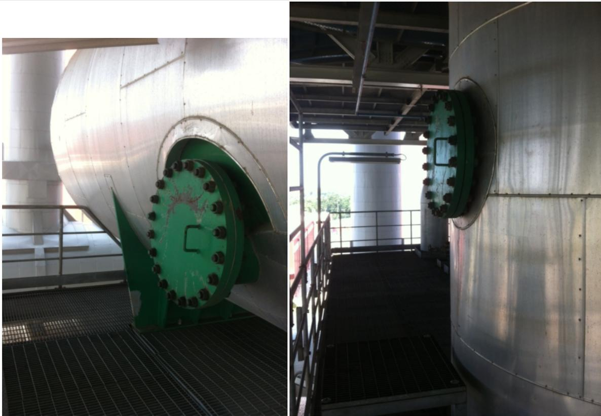
Gli accessi sono due e di tipo orizzontale: uno per il corpo principale ed uno per la torretta degasante soprastante.
