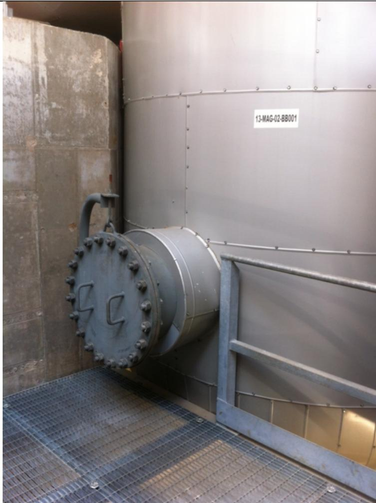
L'accesso è unico e di tipo orizzontale. La sua sezione è circolare del diametro interno di circa 60cm. L'ambiente interno è cilindrico e di una larghezza di circa 3m di diametro. L'altezza è di circa 4m. Prestare attenzione al fondo bombato e all'altezza tra il passo d'uomo e la pavimentazione del drain pot (circa 1m).
