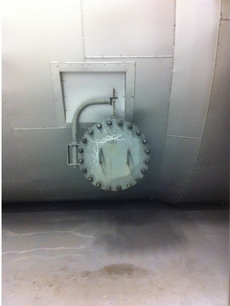
E' presente un solo accesso (nella foto) di forma cilindrica con un diametro minimo di circa 50cm ed una profondità di circa 1m. Per poter agevolare l'entrata o l'uscita (soprattutto in caso di emergenza) si consiglia di introdurre un telo resistente sul quale fare appoggiare l'operatore in modo da agevolarlo trascinando il telo stesso.
