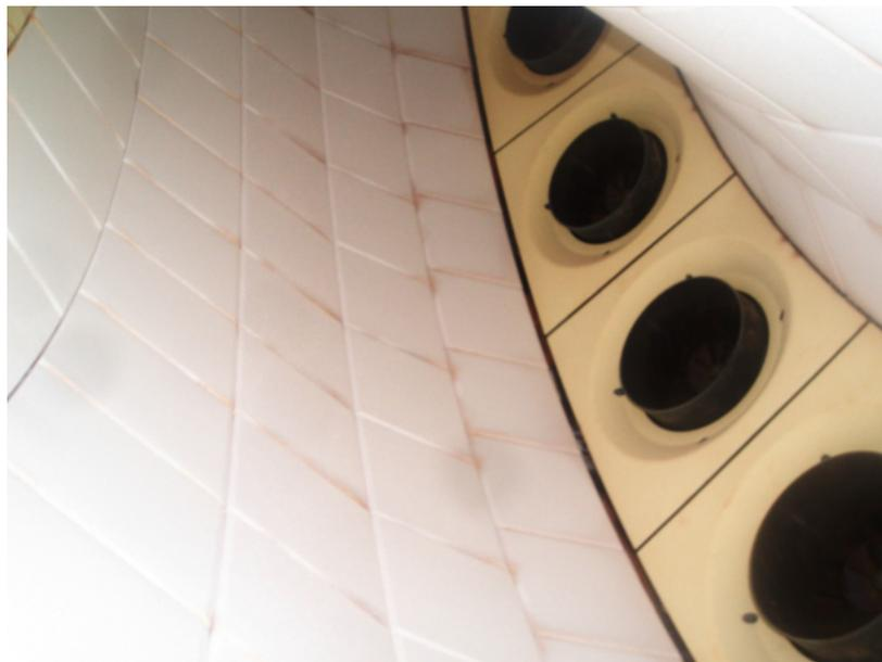
L'accesso alla camera di combustione avviene dal basso verso l'alto (unica apertura) con passo d'uomo avente diametro di 600 mm circa.
