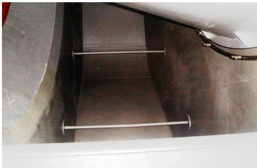
L'accesso all'air intake inferiore è consentito da portelle con apertura verso l'interno della dimensione di circa 70cm\*65cm, poste sui due lati obliqui della camera, lateralmente alla direzione dell'aria in ingresso.
