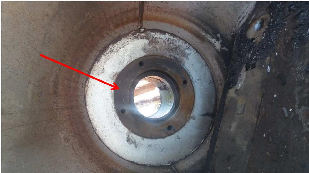
7. (ADDRIZZATURA) E SALDATURA PARTI LESIONATE LAMIERA DI INCONEL DI CONTORNATURA, SABBIAIATURA E VERNICIATURA
