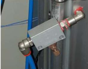
L'iniziativa di miglioramento prevede la sostituzione dei raccordi (TEE, gomiti 90°, ecc.) con nuovi in acciaio inox AISI 316, altamente più performanti e resistenti agli attacchi chimici
