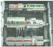
Esecuzione di lavori su quadri elettrici, ossia di una struttura assemblata contenuta in un involucro rigido, costituita da apparecchiature di interruzione, comando e controllo a bassa tensione, oltre che da sbarre, cavi, morsetti, segnalazioni e quanto necessario per la loro corretta interconnessione e per il relativo comando e controllo. Tale struttura ha la funzione di alimentare e, nel caso di guasti o manutenzioni, di scollegare elettricamente le utenze elettriche ad essa connesse.
