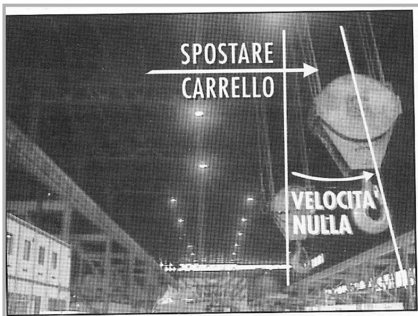
Fig. 3.5-1. Operazione per l'arresto dell'oscillazione del carico.
