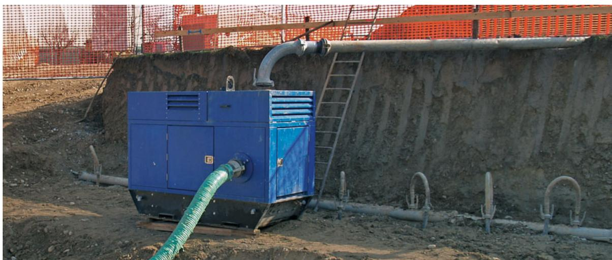
contenenti fanghi, sabbia o argilla, acqua marina, liquidi viscosi o abrasivi. Impiego mobile, ideale per risolvere molte situazioni di emergenza.
