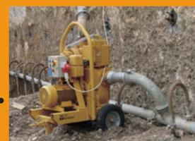
**Sistema wellpoint per l'abbassamento della falda durante le operazioni di scavo**
