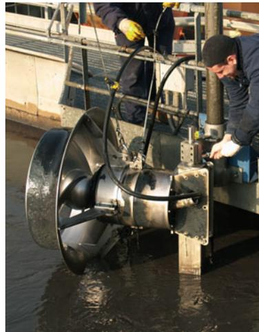
installazione in un'unica vasca di più mixer per generare un unico flusso di miscelazione. Campi di applicazione principali: miscelazione di fluidi in vasche, bacini o in mare; mantenimento in sospensione di contenuti solidi; funzione antighiaccio o contro la formazione di crostoni superficiali.
