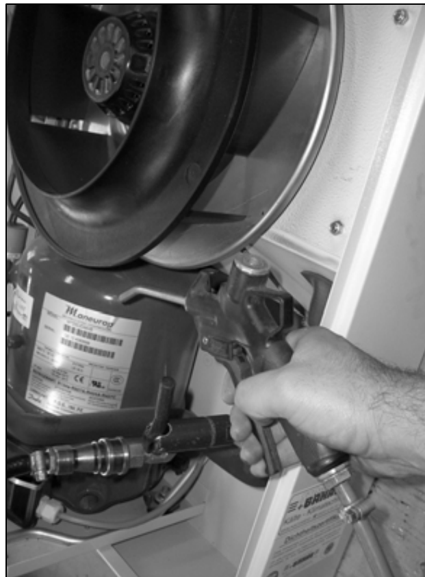
Fig. 52: Soffiare aria compressa sui tubi dello scambiatore di calore e nel vano compressore (2)
