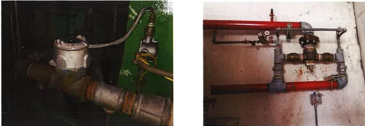
Fig. 1- Confronto valvola pirotecnica (da sostituire) e valvola a solenoide di esempio
