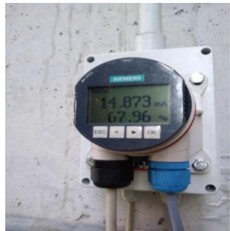
Visualizzatore di campo del livello dell'acido cloridrico nel serbatoio
