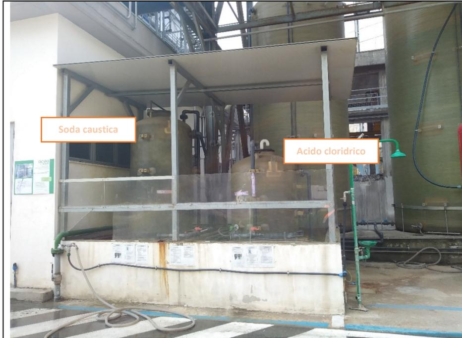
Serbatoi di stoccaggio acido cloridrico e soda caustica
