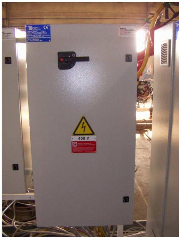
**Figura 6.2-4 - Esempio armadio disgiuntore di saldatura – Vista esterna**
