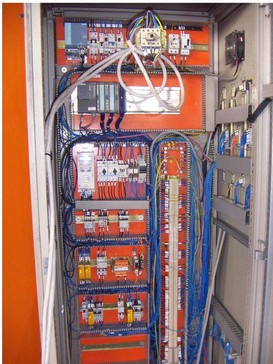
**Figura 6.2-7 - Esempio armadio servizi / logica generale – Vista interna**
