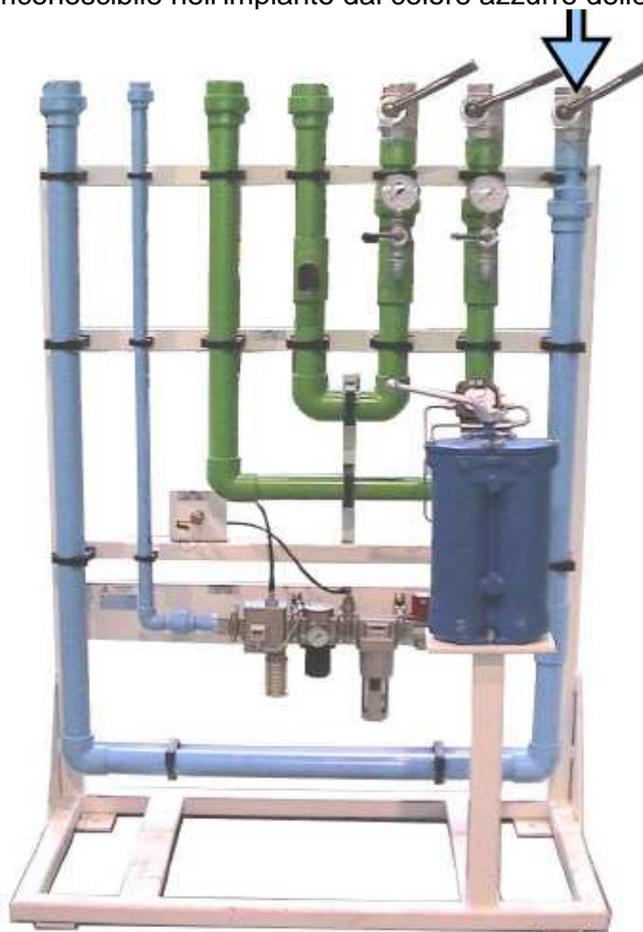
**Figura 6.9-1 – Esempio pannello fluidico di distribuzione – Aria /Acqua**
