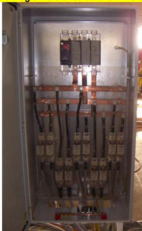
**Figura 6.2-5 - Esempio armadio disgiuntore di saldatura – Pannello interno**
