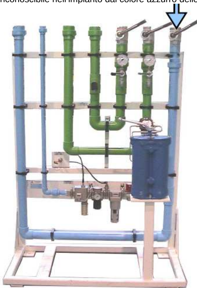
Figura 6.9-1 – Esempio pannello fluidico di distribuzione – Aria /Acqua
