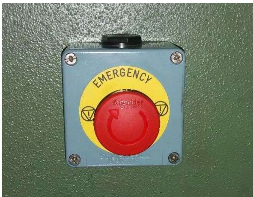
Figura 1-3: Pulsantiere di Emergenza
