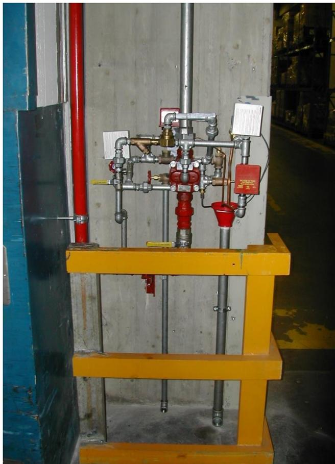
**Collettore valvole a diluvio discensore singolo settore "D"**
