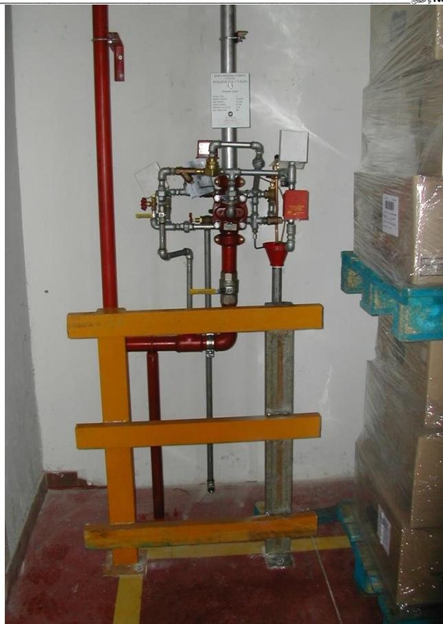
**Collettore valvole a diluvio montacarichi settori "C"**
