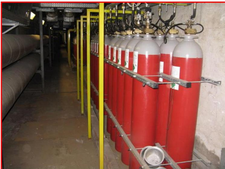
E' stato previsto un ulteriore sistema di spegnimento (backup), che potrebbe essere azionato manualmente nel caso in cui i sistemi di spegnimento tradizionali (estintori) e/o l'impianto CO<sub>2</sub> non fossero in grado di adempiere allo spegnimento dell'incendio.
