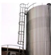
Le scale a pioli di altezza superiore a m 5, fissate su pareti o incastellature verticali o aventi una inclinazione superiore a 75 gradi, **devono essere provviste, a partire da m 2,50 dal pavimento o dai ripiani, di una solida gabbia metallica di protezione** avente maglie o aperture di ampiezza tale da impedire la caduta accidentale della persona verso l'esterno.
