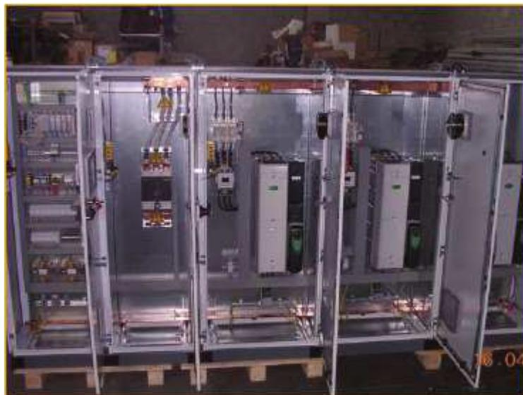
Quadro Fiat Cassino per la gestione automatica delle pompe di alimento saldatrici reparto saldatura (mantenimento pressione costante con variazione di set point tramite calendario)
