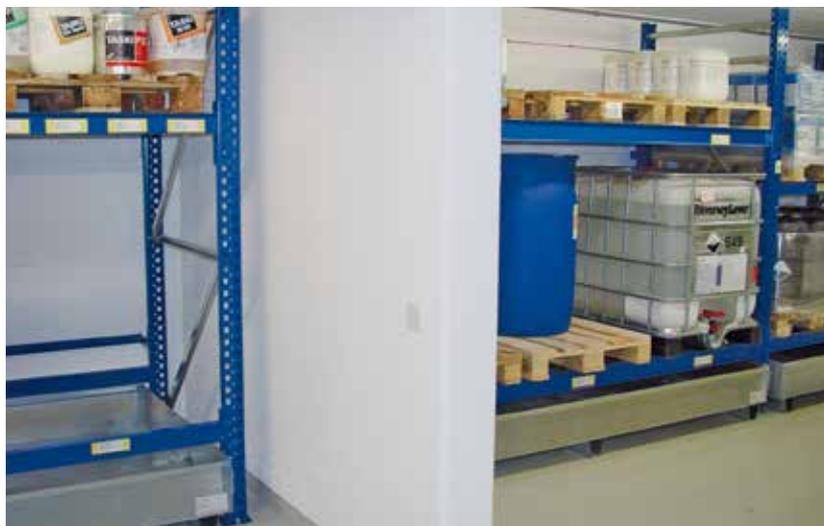
Stoccaggio diviso (muri di schermatura e vasche di raccolta separate) nello stesso compartimento tagliafuoco
