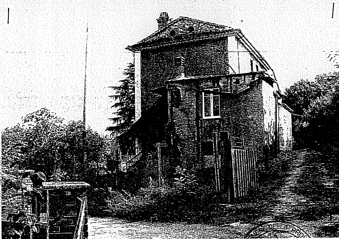
FOTO N.1: Vista lato nord
