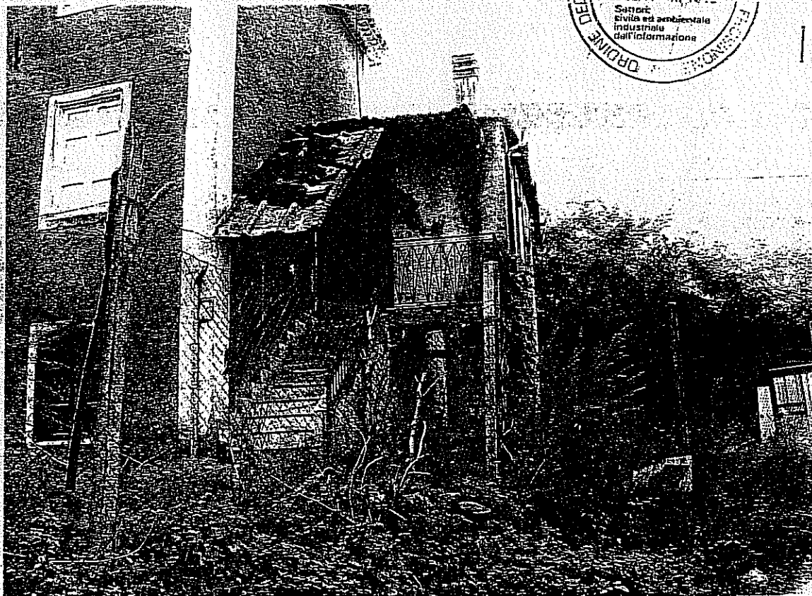
FOTO N.2: Vista lato nord-est: particolare scala con tettoia in lastre di Eternit
