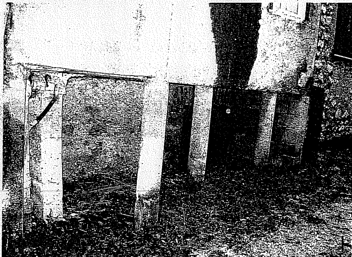
FOTO N.6: Vista lato ovest: particolare piastrini in cemento
