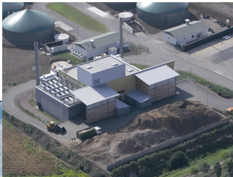
Impianto di cogenerazione di Alperstedt
